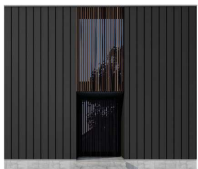
耐久性の高い鋼板と 木格子の家
