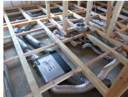
熱交換型換気システム
